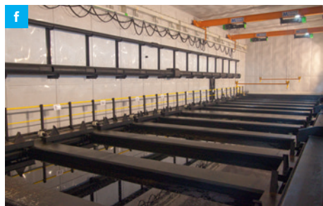
Linka pro předúpravu zevnitř s obložením stěn z polyetylénu
